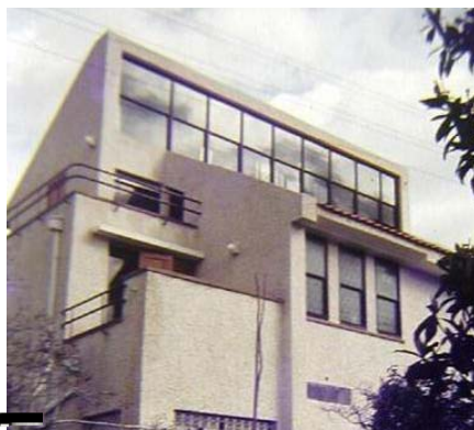
איור 1.19 – הזרמת אוויר חם מחממה על הגג לקומה הראשונה המוצללת על ידי הבניין השכן (ישראל)
